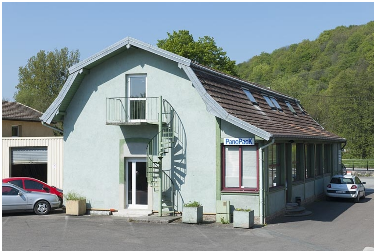
Bureaux. Vue depuis le nord-est.
