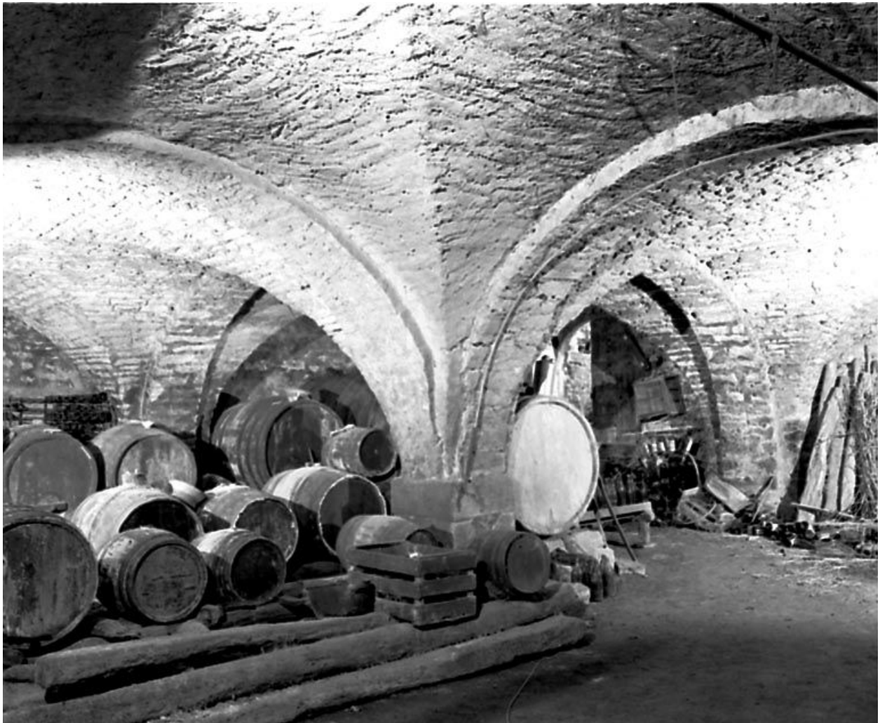
Vue de la cave voûtée.
