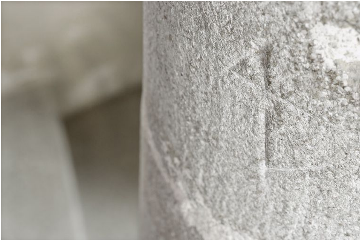
Détail de l'escalier en vis du grand logis : marque de maçon.
