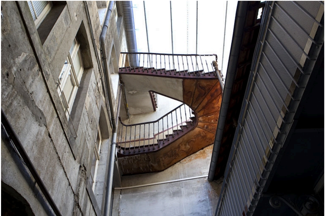
Détail sur cour de l'escalier extérieur en métal entre le premier et le dernier étage.
