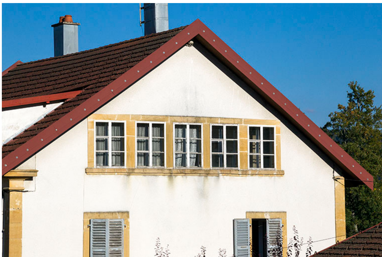
Pignon occidental : fenêtres multiples.
