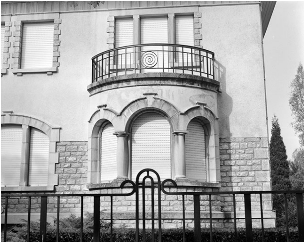
Détail : la logette du 16 avenue Albert 1er.
