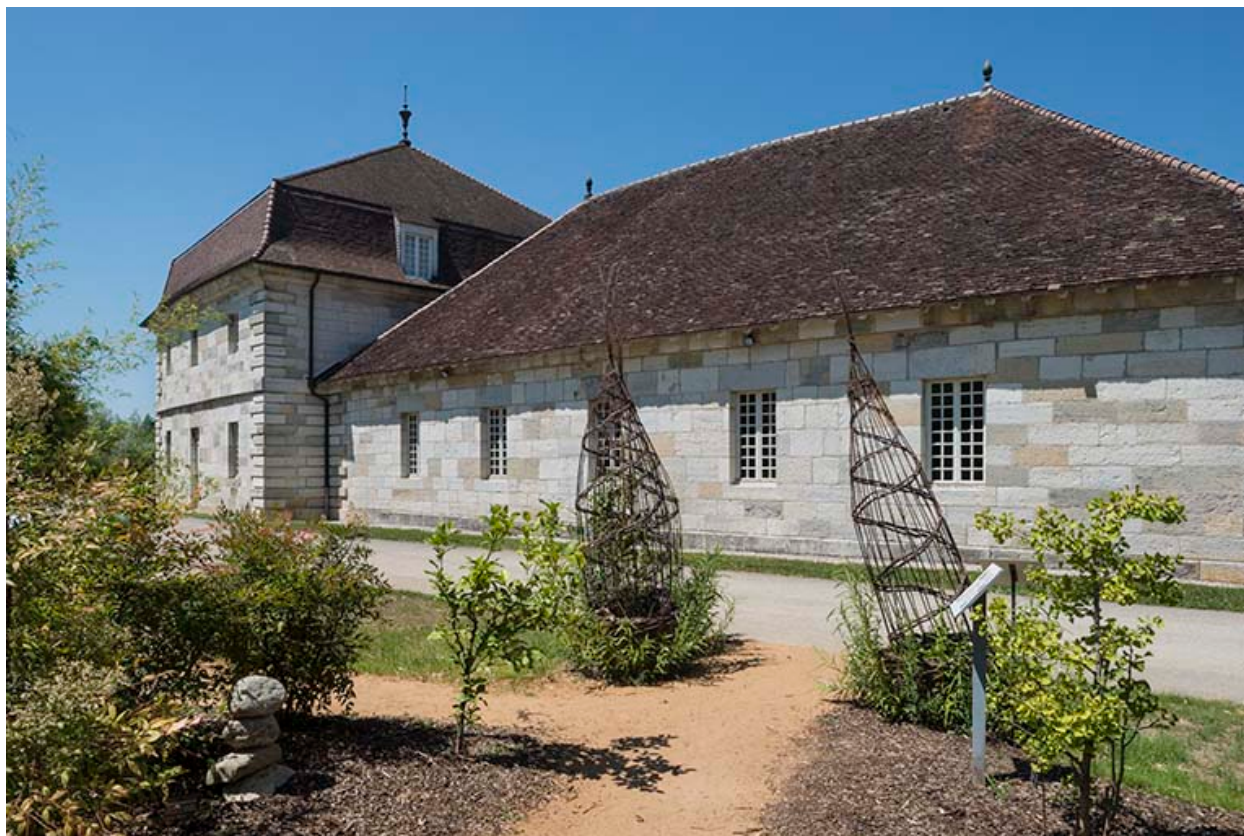
Façade postérieure de la tonnellerie.
