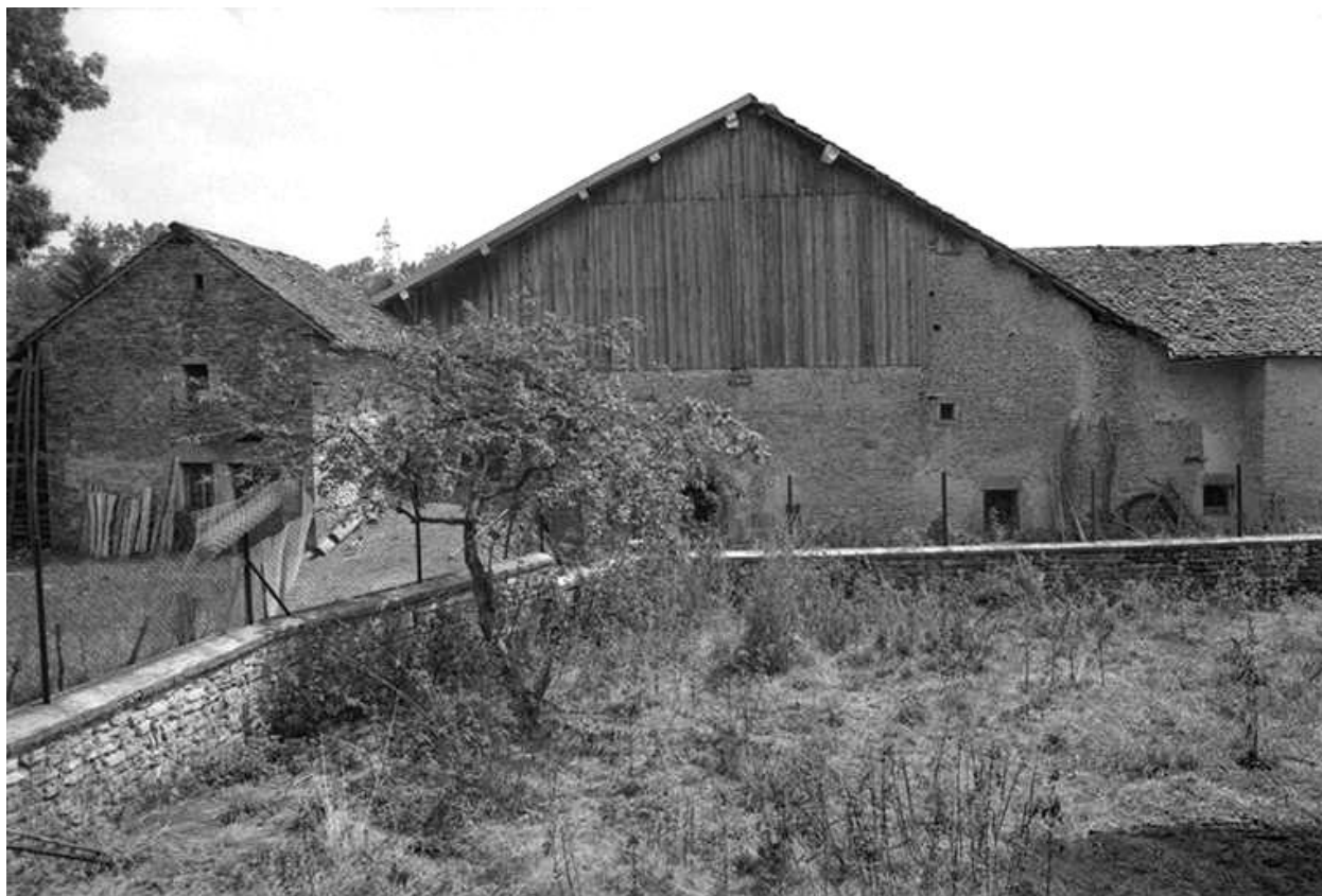
Ferme située au lieudit Les Cloutiers.
