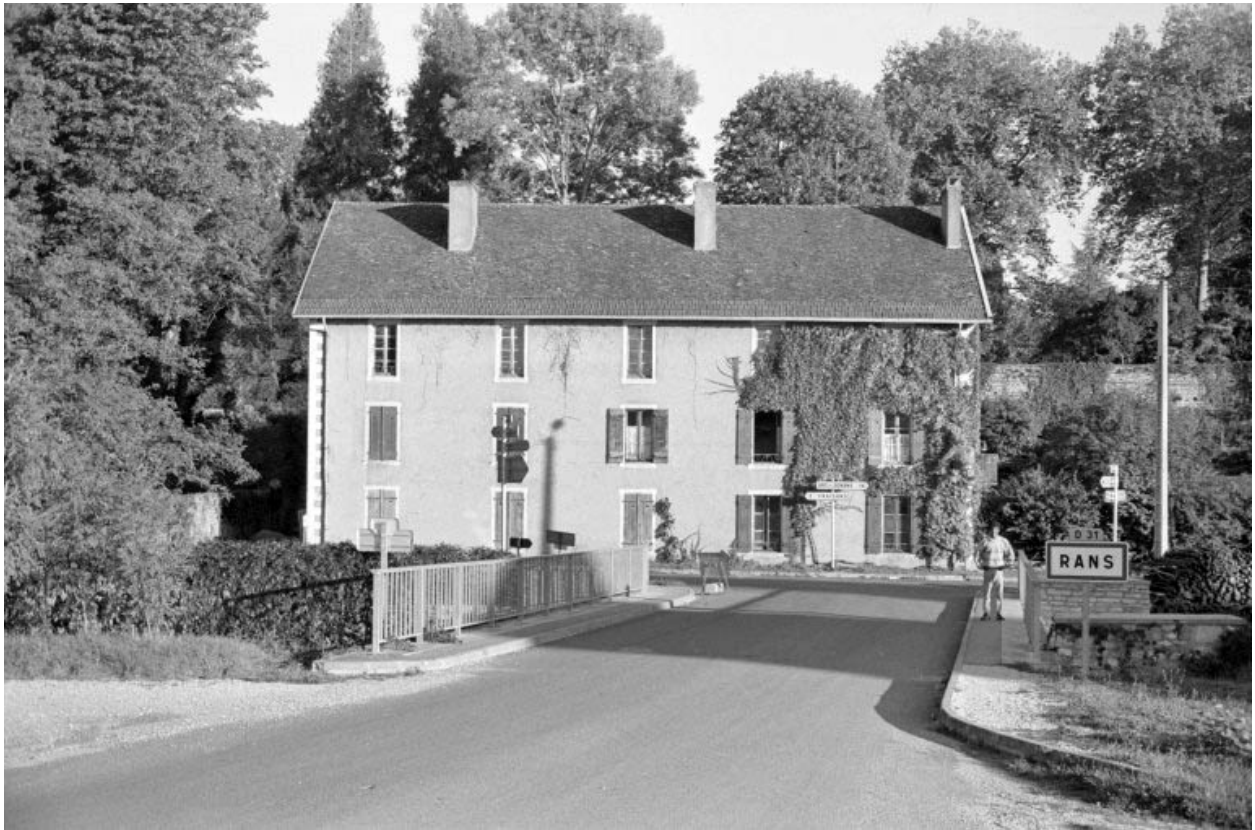
Façade antérieure du logement d'ouvriers (J).
