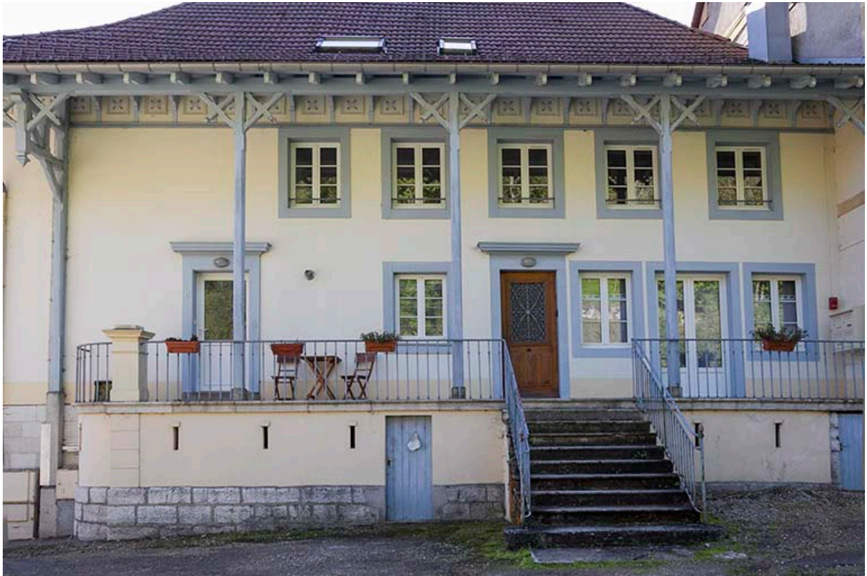
Premier atelier de fabrication : façade antérieure.
