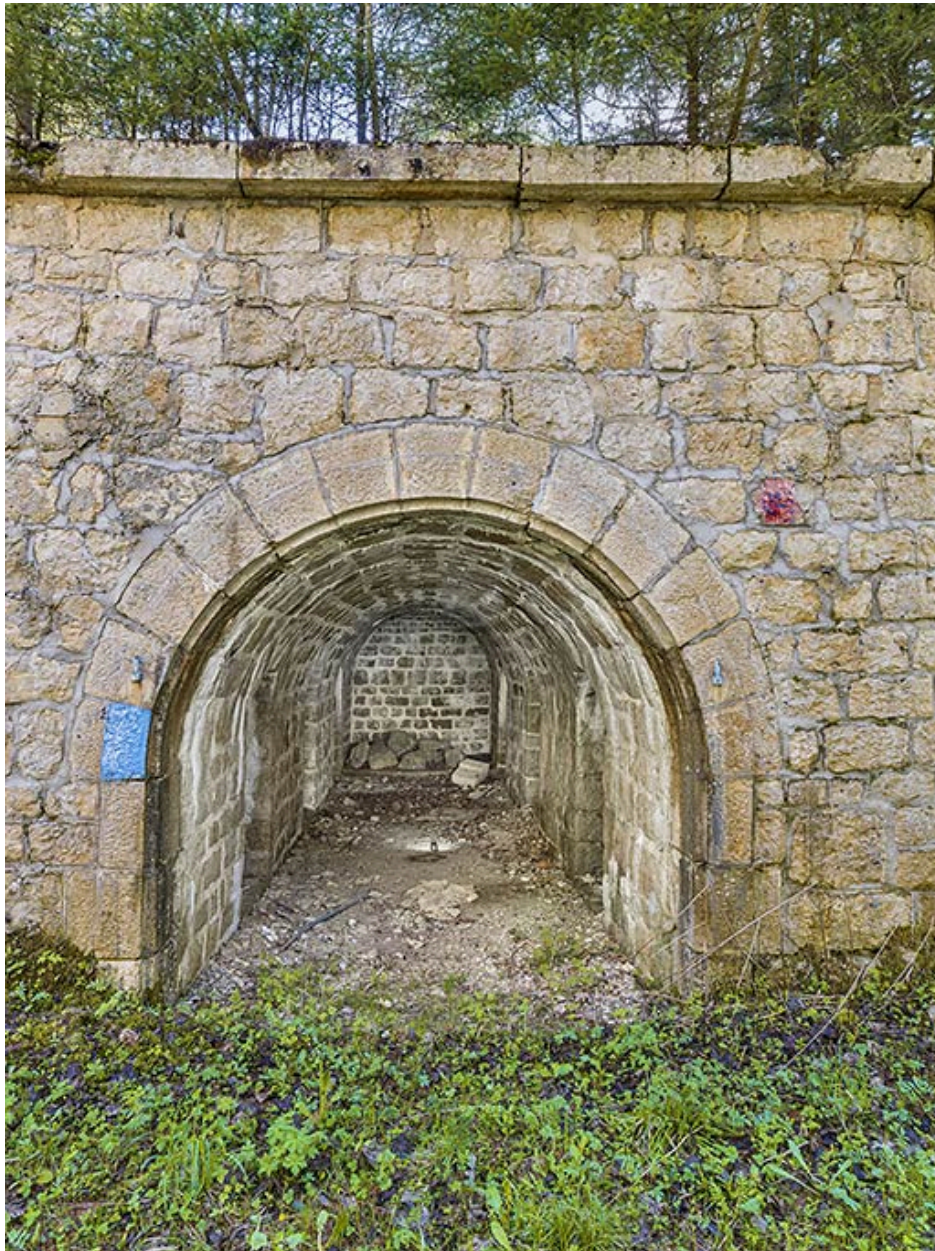
La casemate de la traverse-abri.
