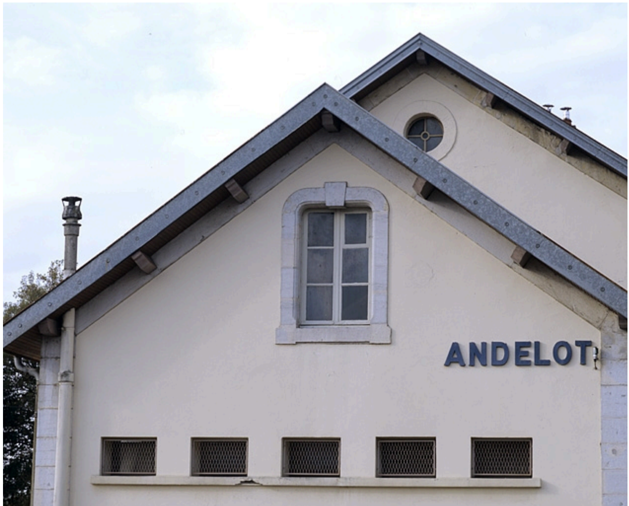
Bâtiment des voyageurs : pignon de l'aile droite.
