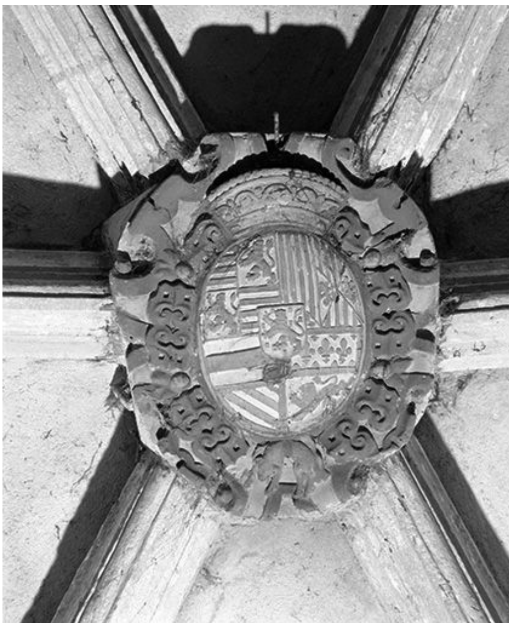
Clef de voûte du chœur.
