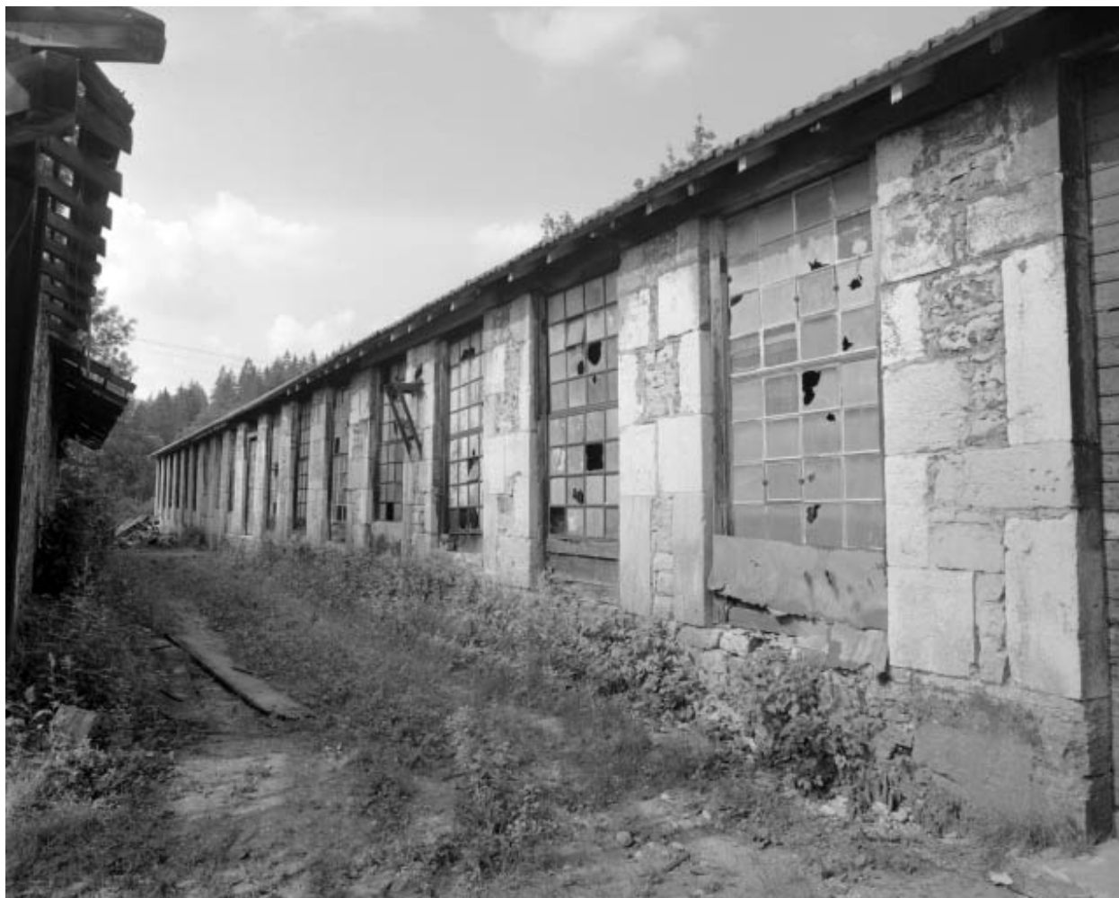
Façade antérieure de la clouterie.
