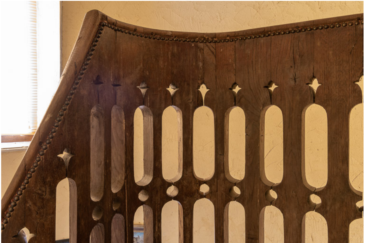
Escalier en vis, rampe d'appui.
