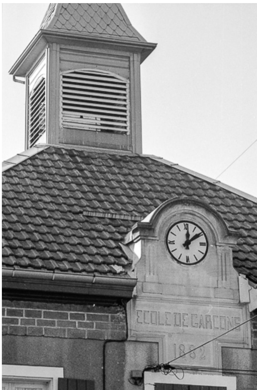
Façade antérieure : détail.
