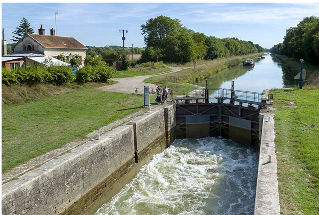
Le sas de l'écluse.
