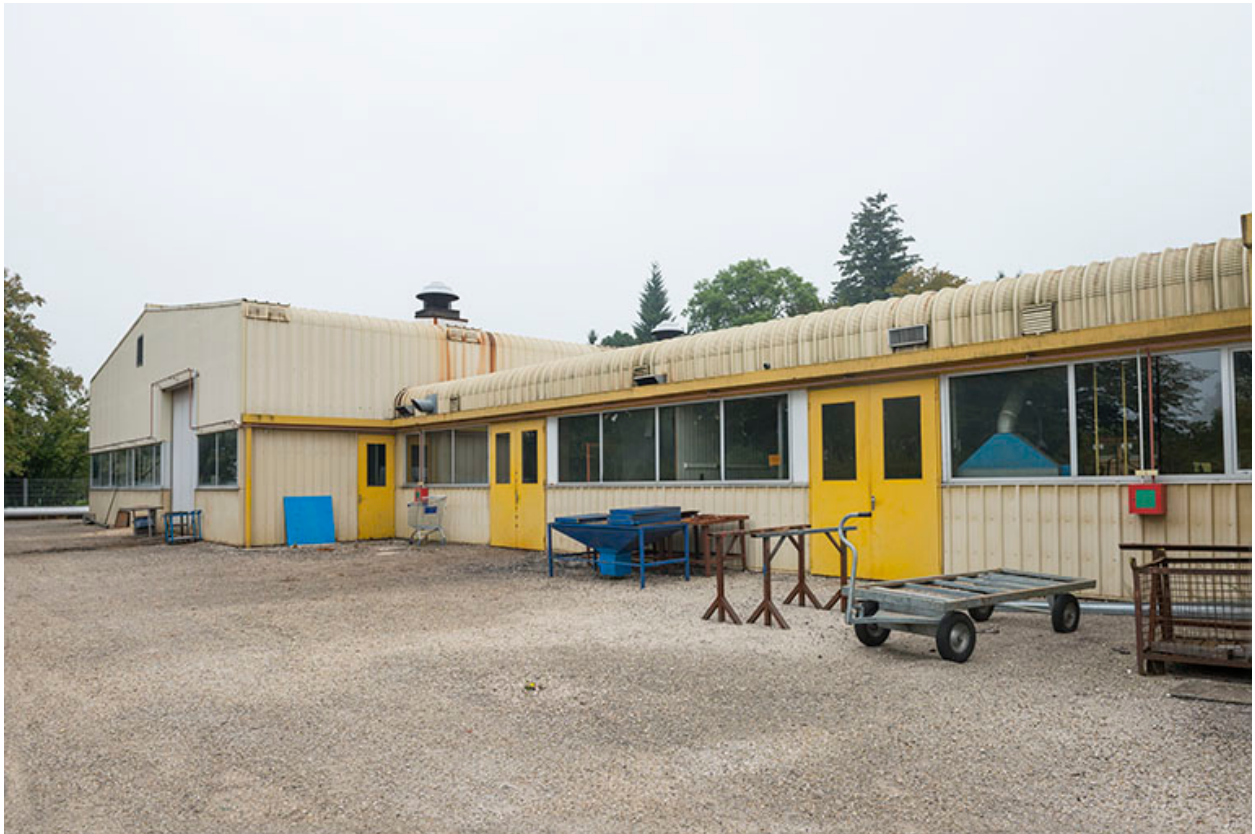
Ateliers : façade antérieure.
