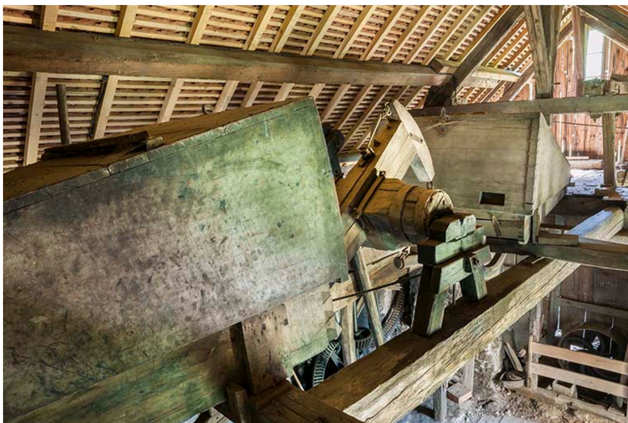
La machine soufflante vue du dessus.
