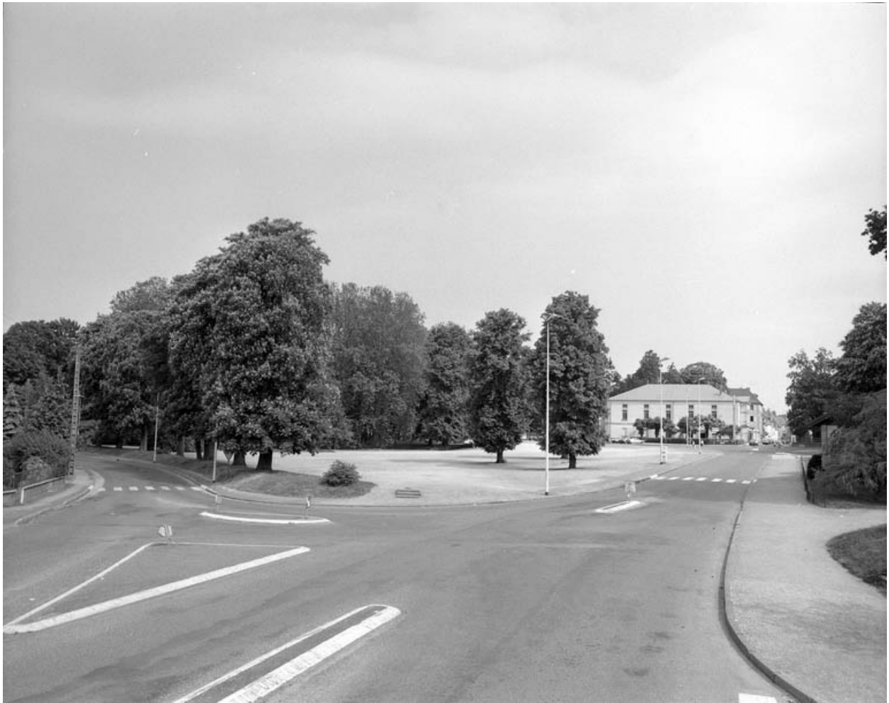
Vue d'ensemble éloignée.
