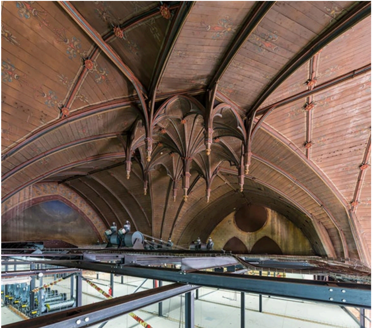
Croisée du transept : charpente lambrissée.
