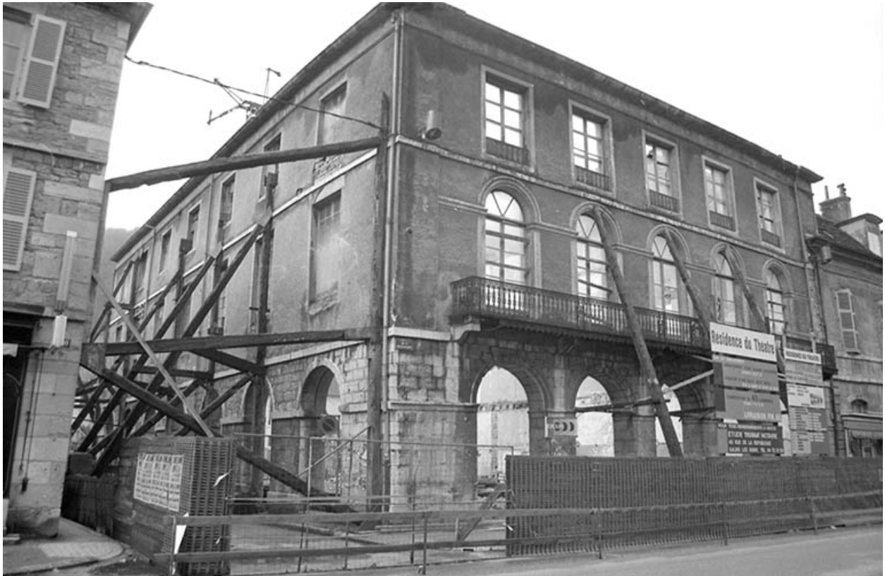
Le théâtre en chantier. Vue depuis le sud-est, s.d. [1988].
