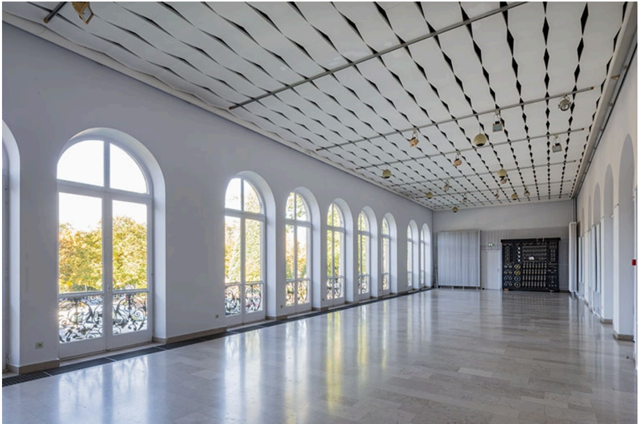
Galerie, vue en direction du nord-ouest.
