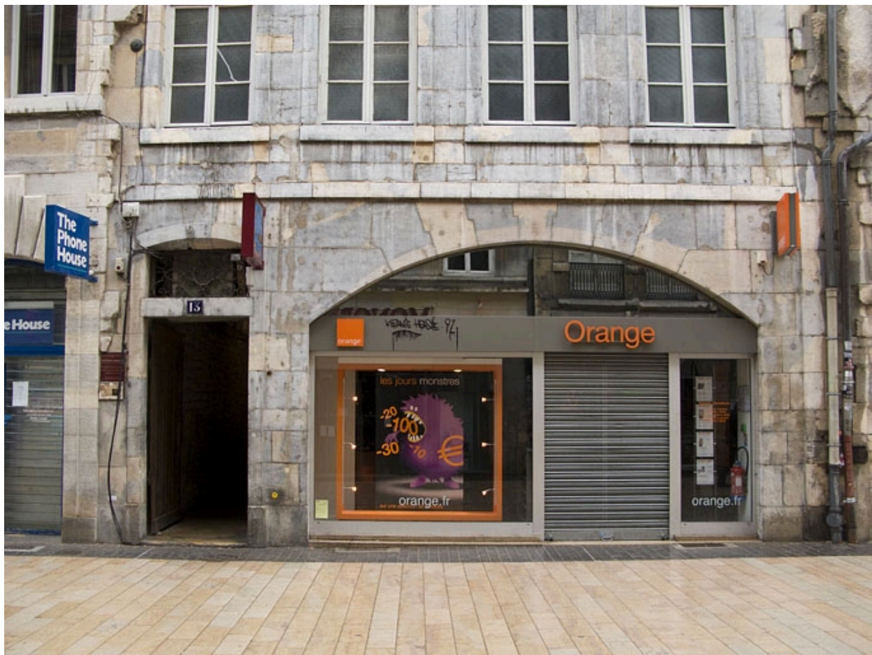
Détail du rez-de-chaussée de la façade antérieure du 13 Grande Rue : de face.
