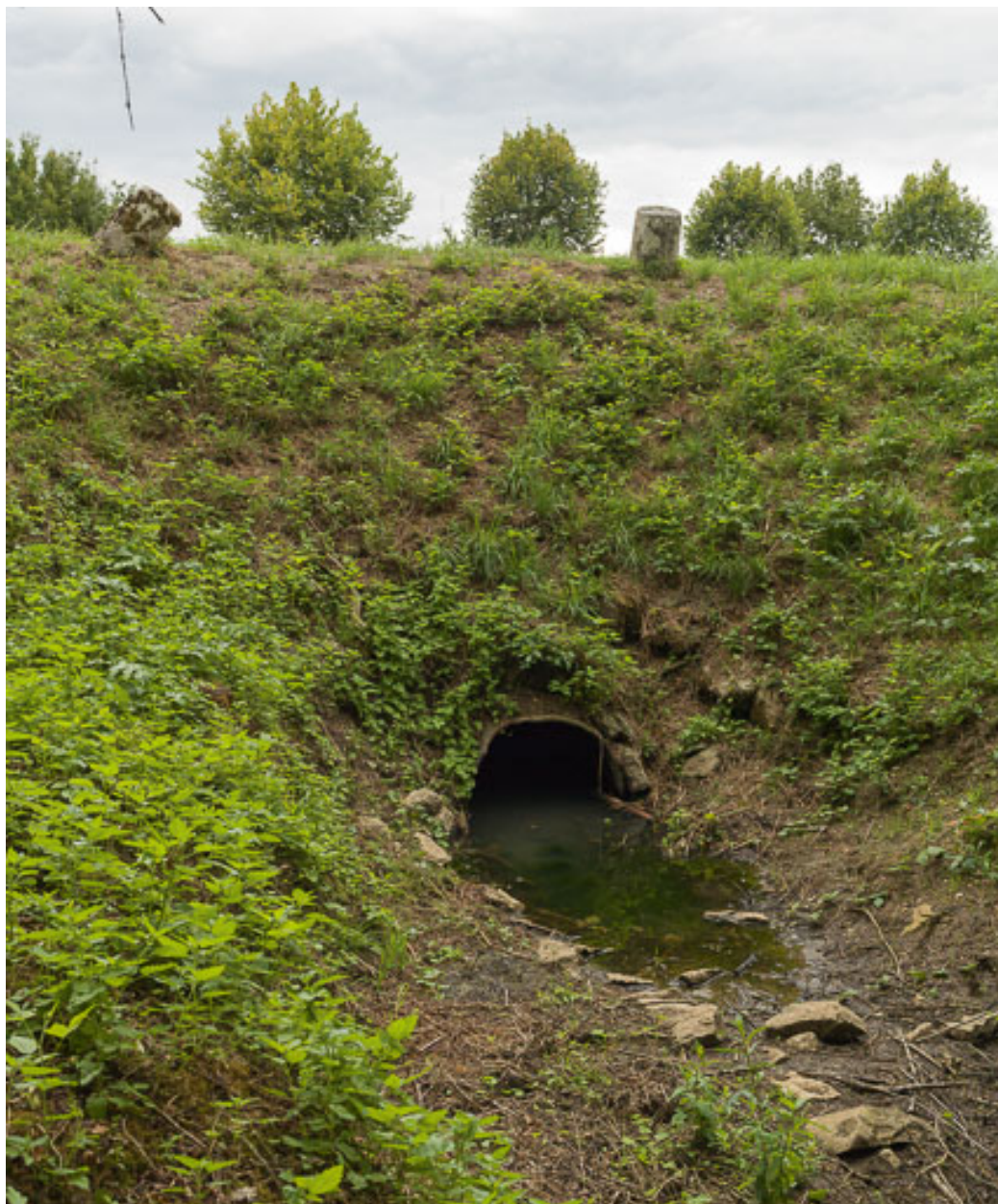
Vue de l'aqueduc.
