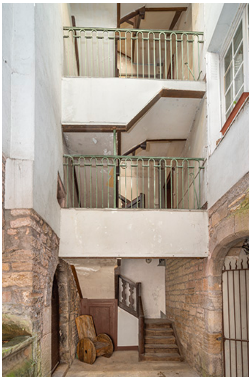
Cage d'escalier au sud de la cour.
