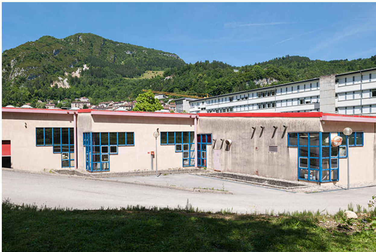
Atelier, ancien atelier mécanique : façade latérale sud.
