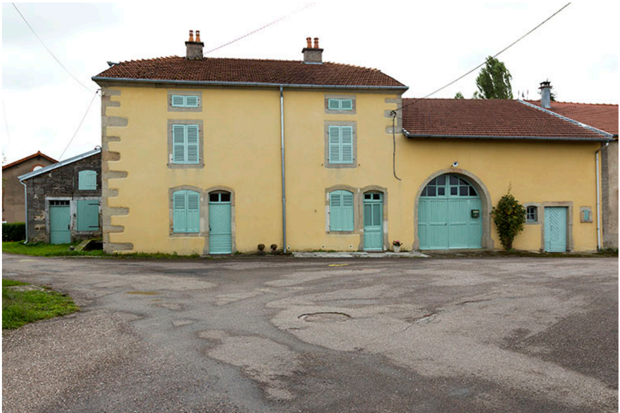
Ferme, rue de la Pompe.
