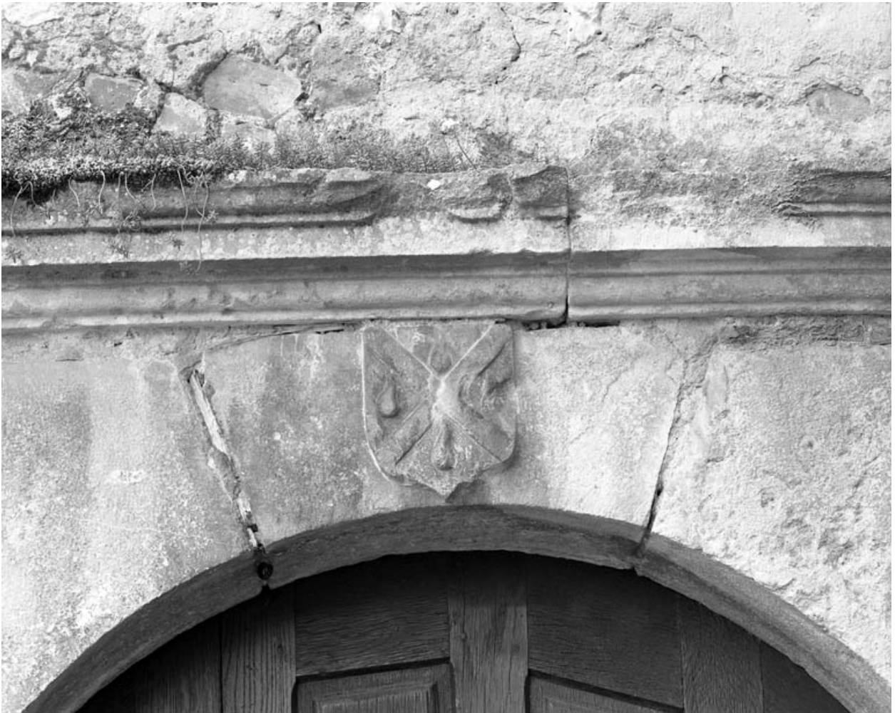
Partie gauche du couvent : détail du blason sur la porte d'entrée de l'escalier du bâtiment en fond de cour.
