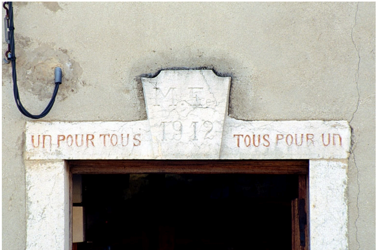
Linteau de la porte d'entrée.
