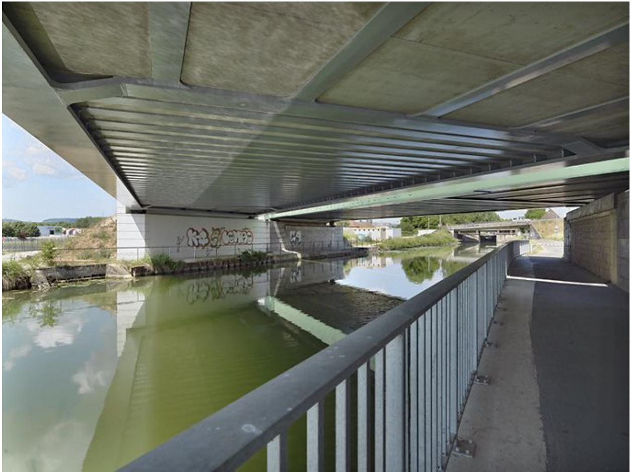
Vue du dessous du tablier.
