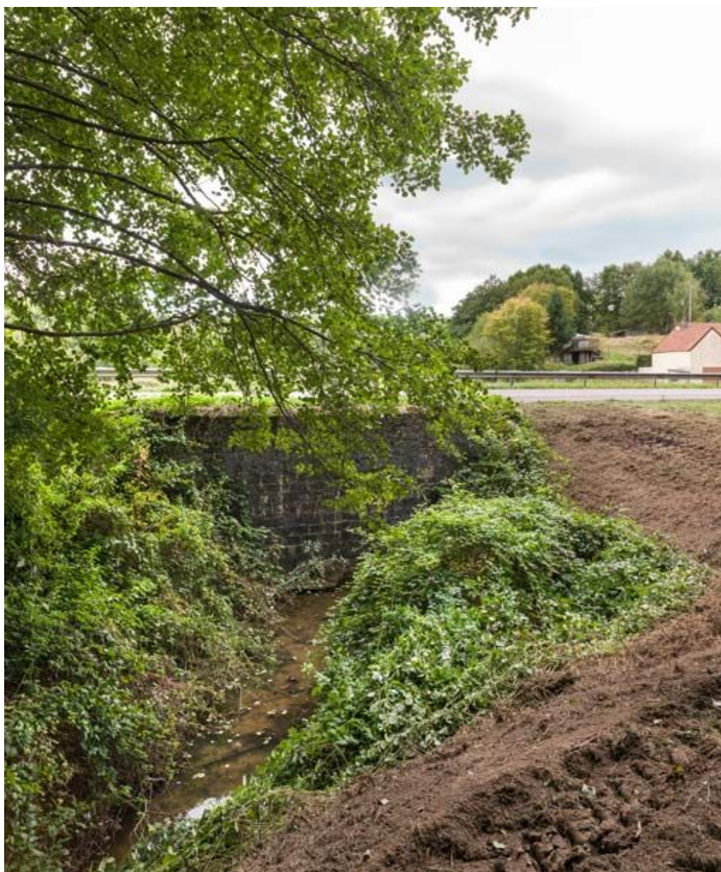
Vue de l'aqueduc.
