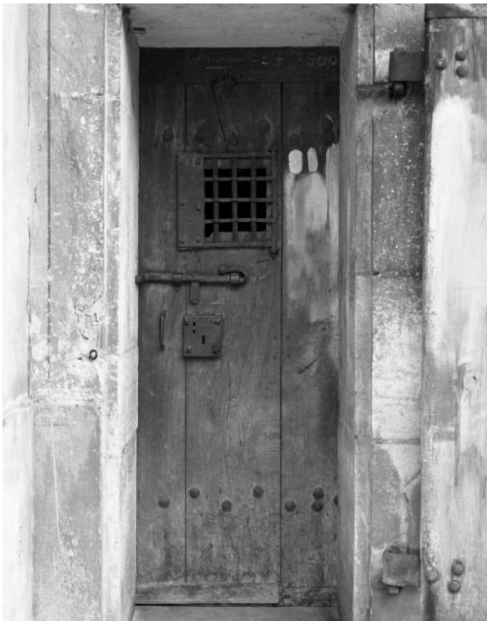
Ancien bâtiment des prisons, porte.
