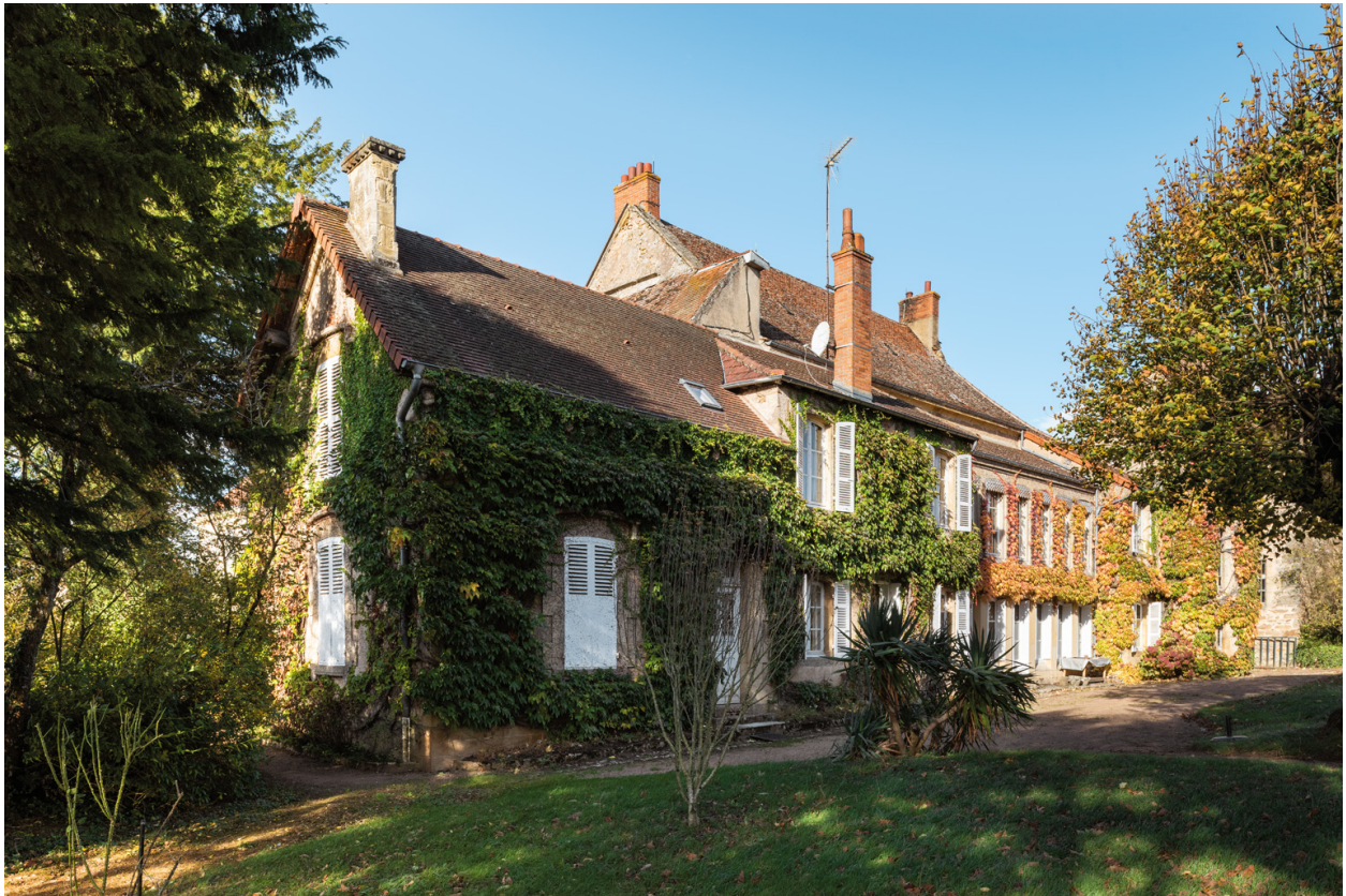
Le logis vu depuis le sud-ouest.
