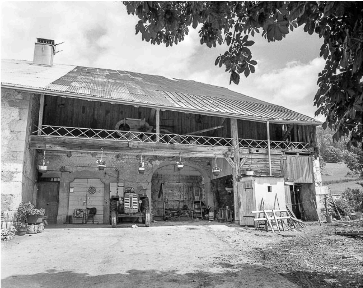
Une ferme avec portes d'entrées sur goutterot.
