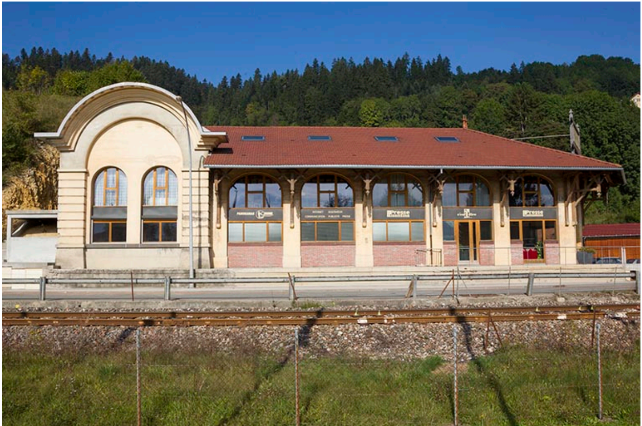
Ateliers de traitement des fûts (à gauche) et de conditionnement : façade orientale.
