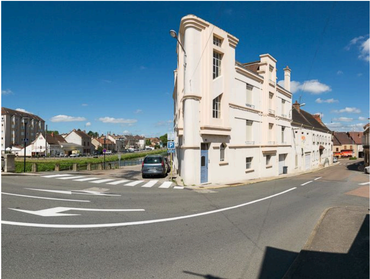
Vue de l'immeuble de style paquebot.
