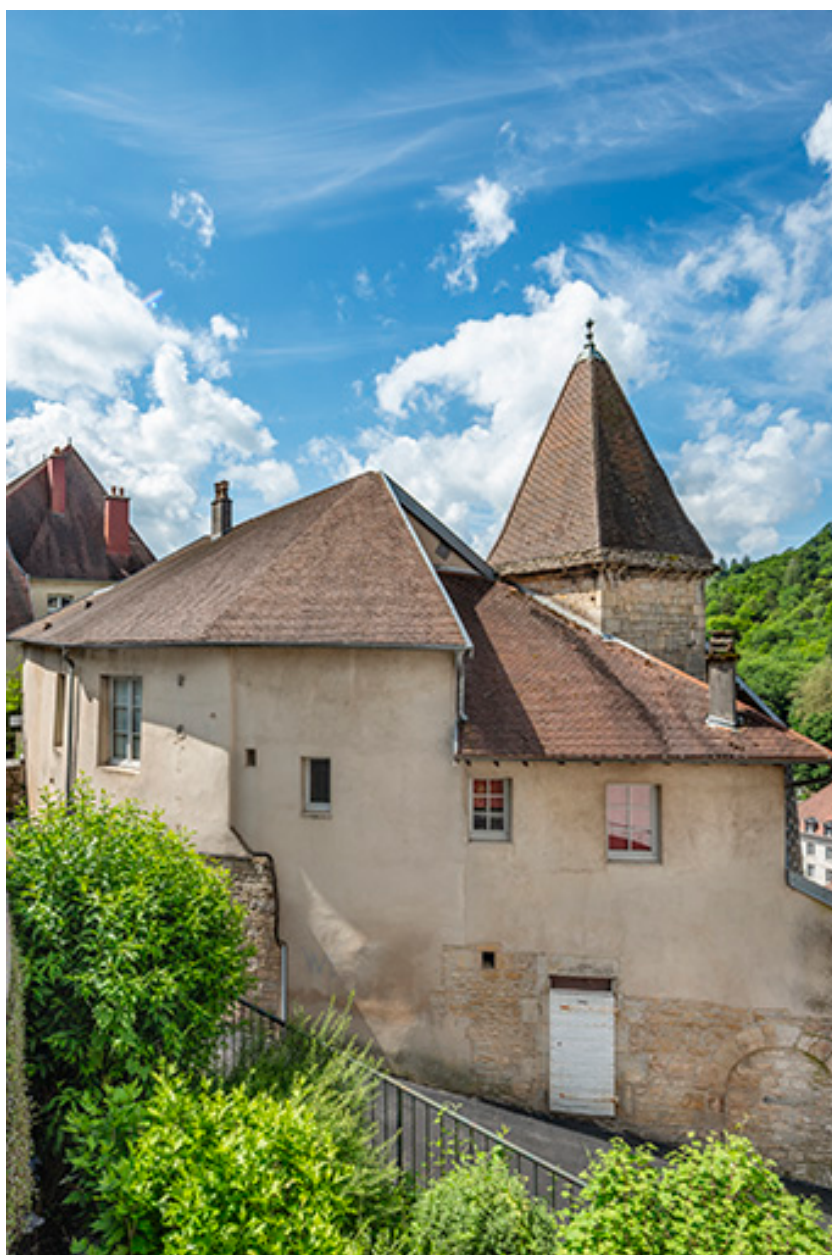
Vue plongeante depuis le nord-est.
