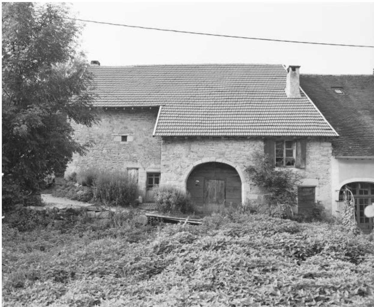
Ferme située rue du Tonkin.
