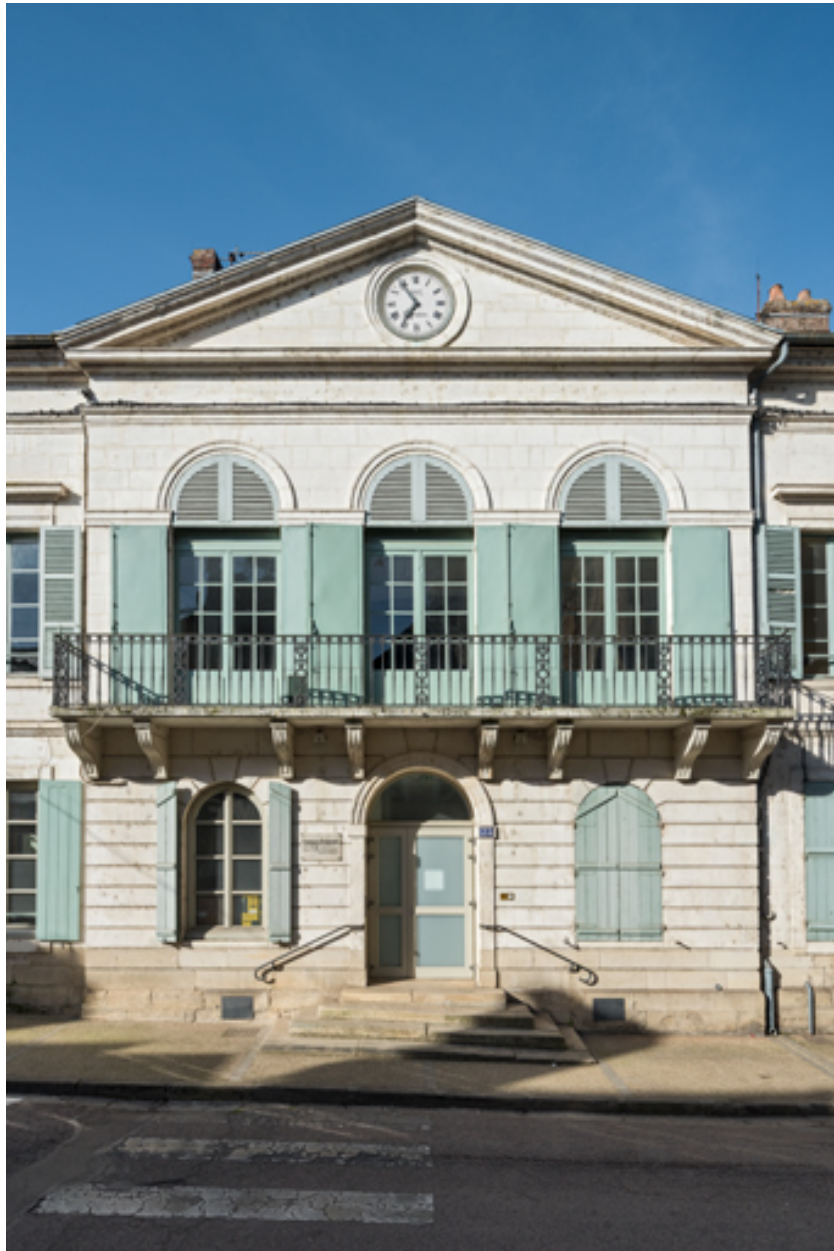
Façade antérieure : avant-corps central.
