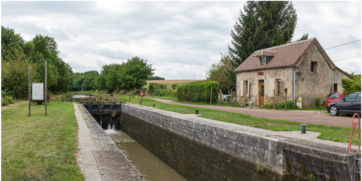
Le site d'écluse
