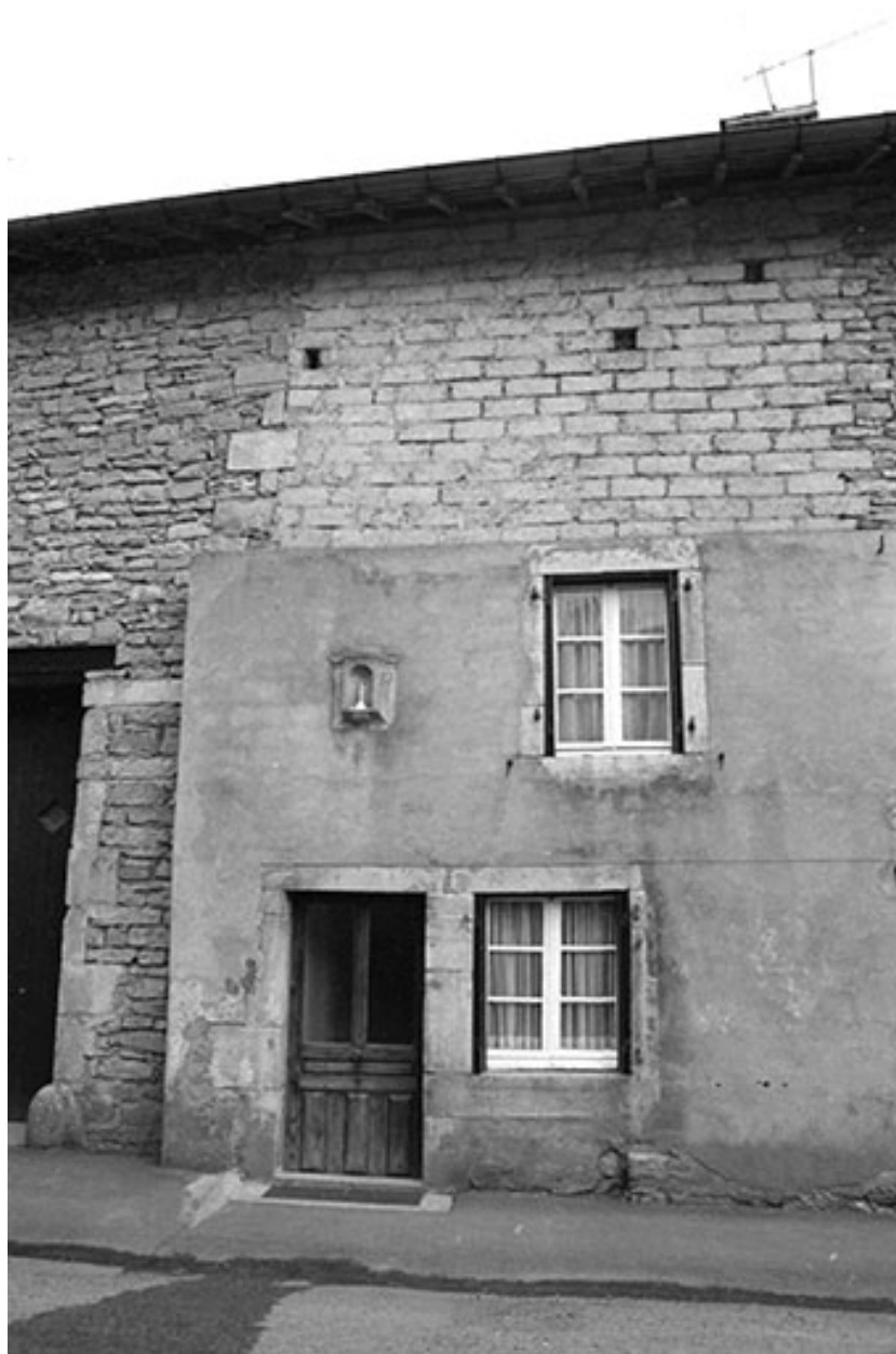
Maison située au lieudit Coin du Dessus, datée de 1728 (?).
