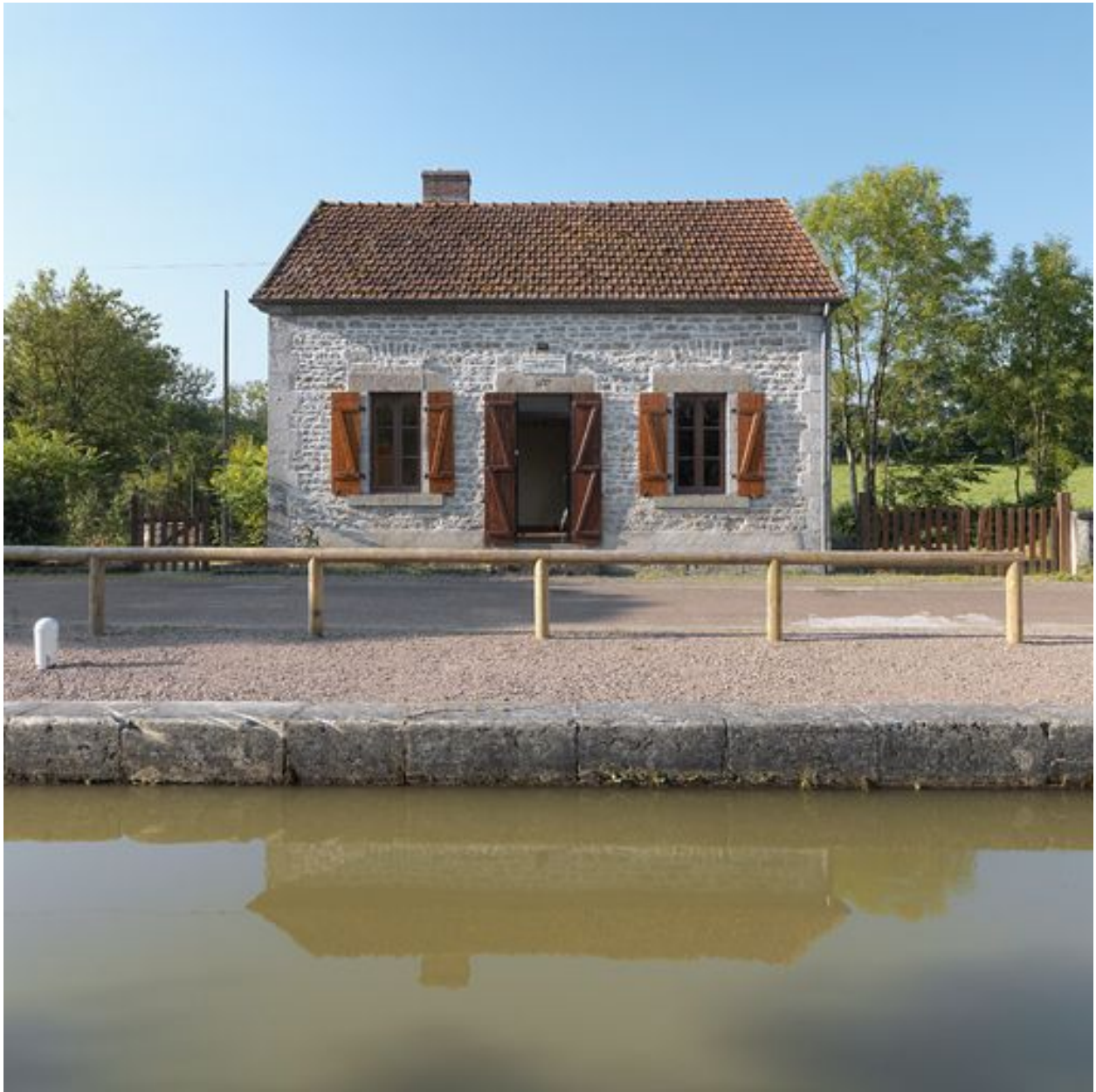
La maison éclusière : vue de face.
