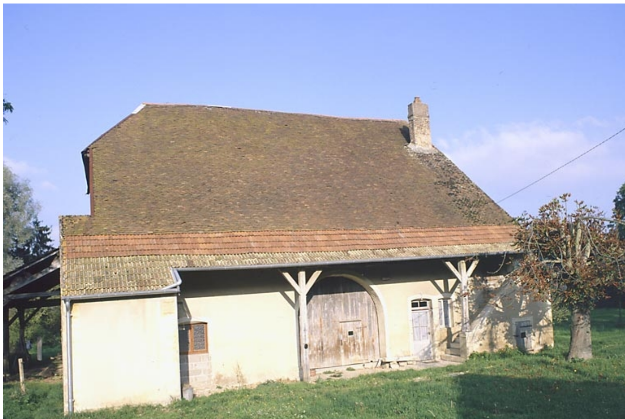
Ferme située rue de la Fontaine : vue d'ensemble.
