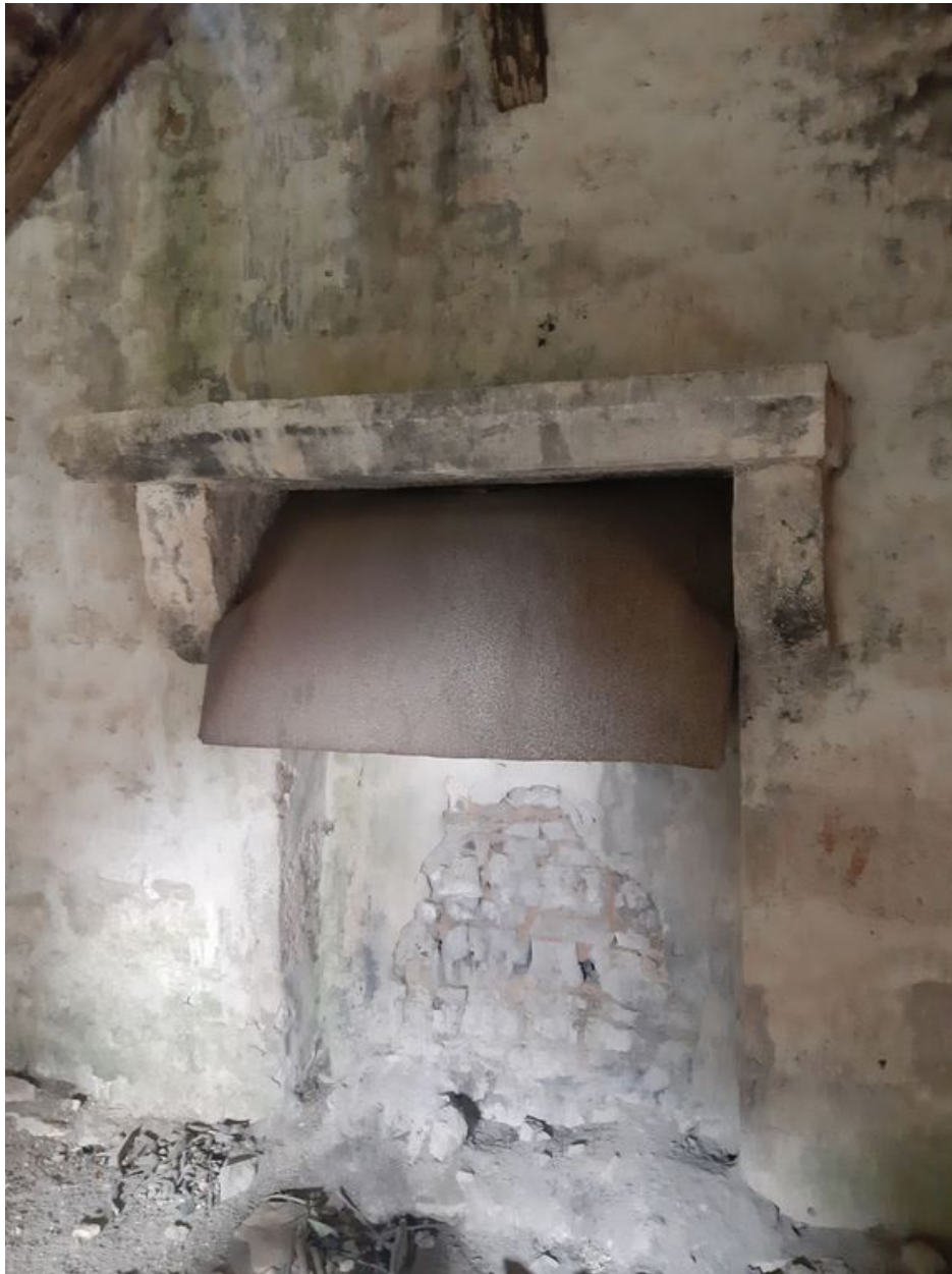
Vue de la cheminée adossée au mur pignon nord.
