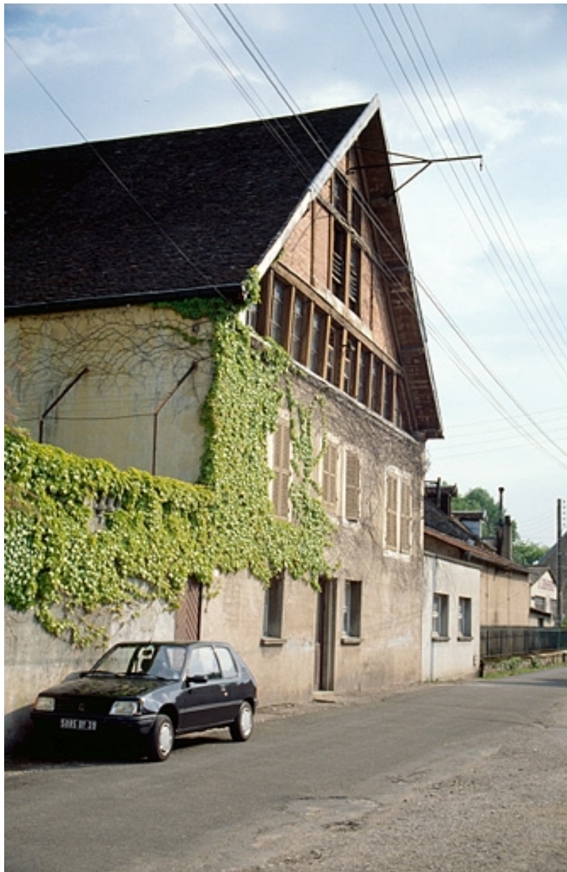
Façade antérieure de l'atelier de fabrication (J).
