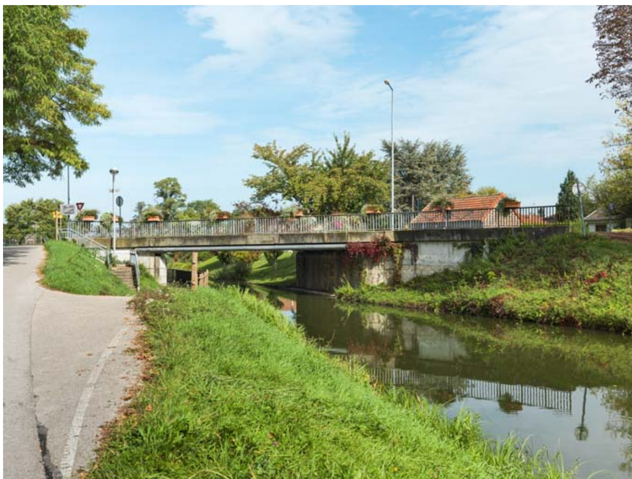
Vue d'ensemble du pont.
