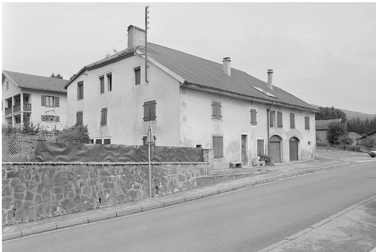
Face sud et façade sur rue.
