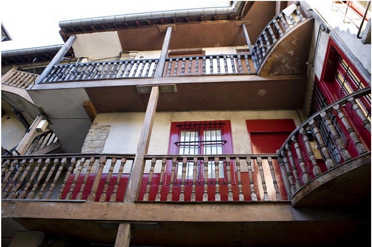
Détail des coursières prolongeant l'escalier à cage ouverte.
