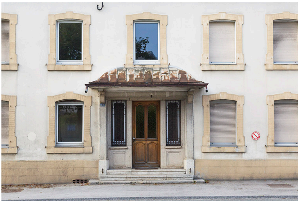
Façade antérieure : entrée de l'atelier de fabrication.
